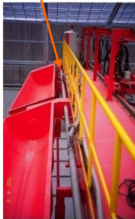
汚水散布パイプ
